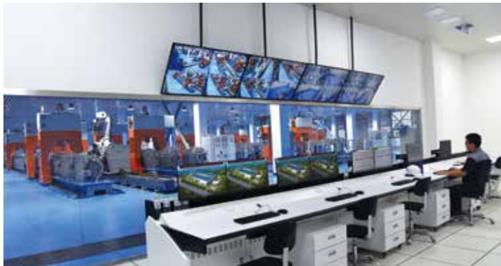
熔压车间监控中心
