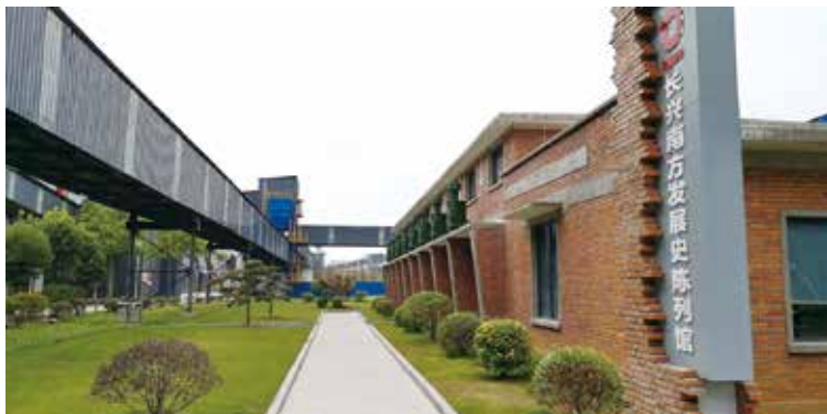
空压机房变身陈列馆
