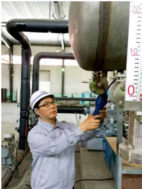
在试验场检测系统密闭性
