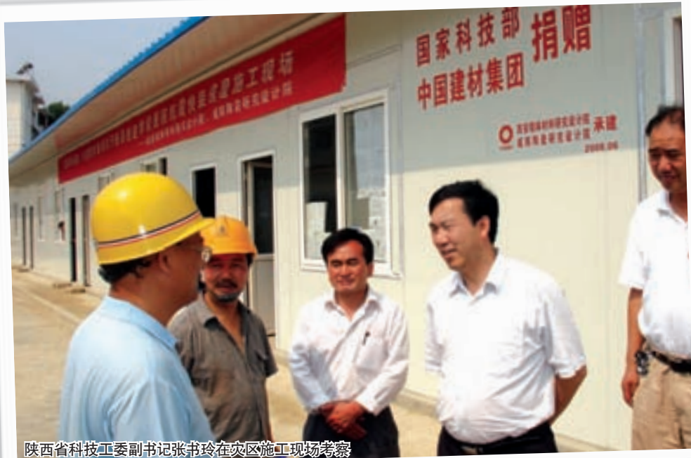
陕西省科技工委副书记张书玲在灾区施工现场考察
