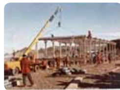
一栋钢结构安装完毕
