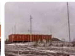
长城站及气象观测场, 通讯天线塔
