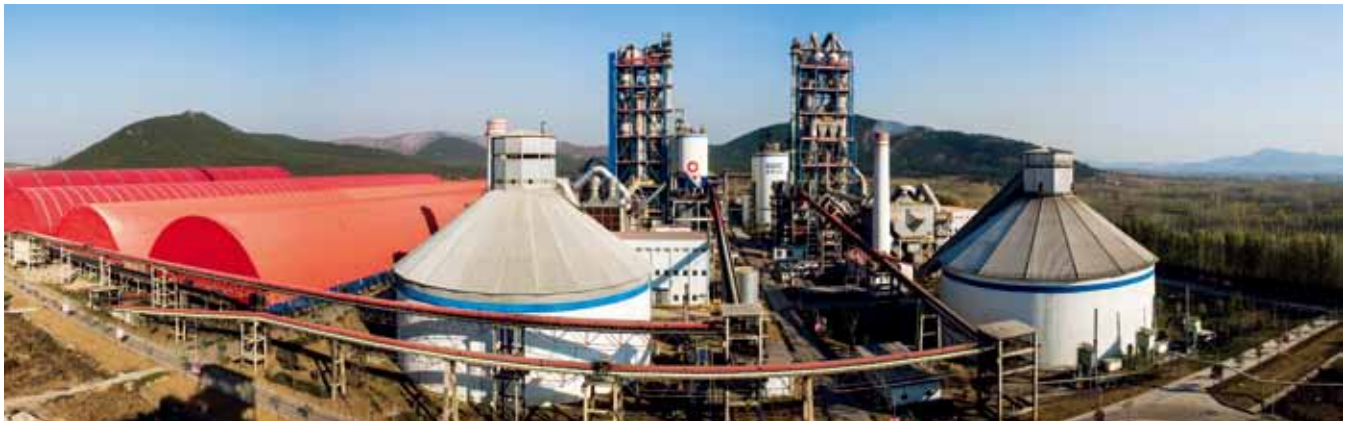
双万吨水泥生产线
